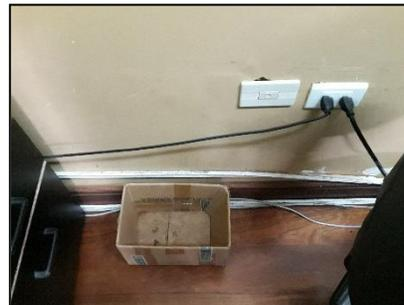
Ilustración 8. Ausencia de uso de regletas de desconexión. Fuente: Autor.
