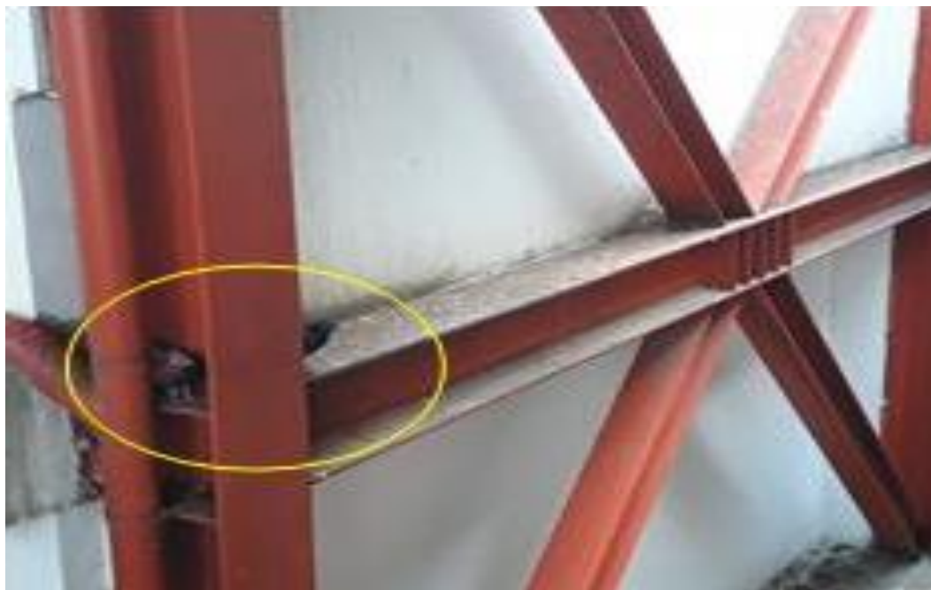
Figura 2. Presencia de Anidado en Estructura Metálica Ubica en Escaleras. Fuente:
