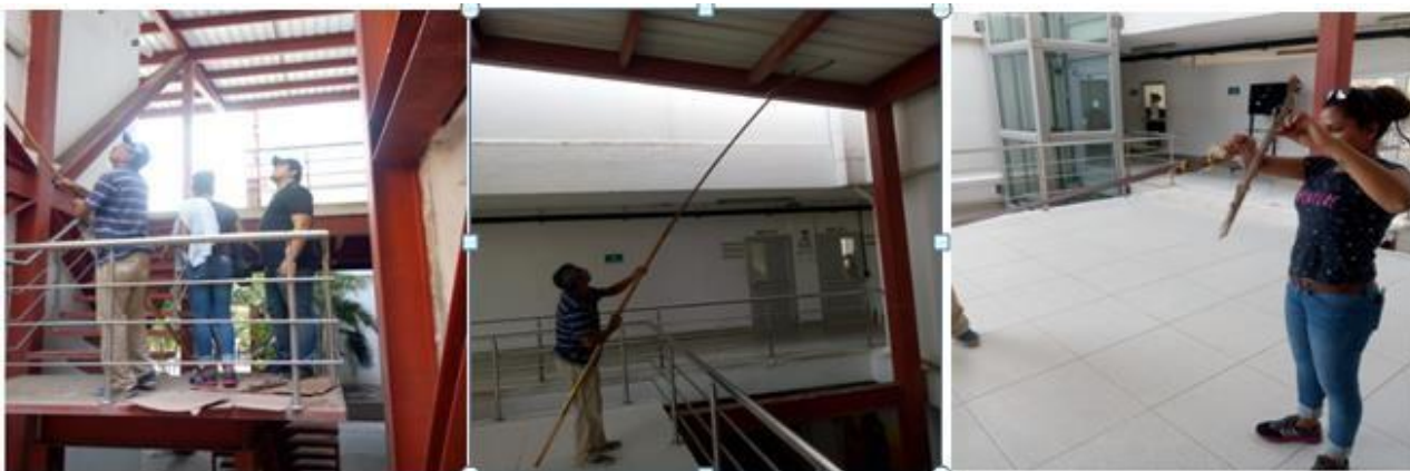
Figura 26. Colocación de tallos de Lata. Fuente: los autores.
