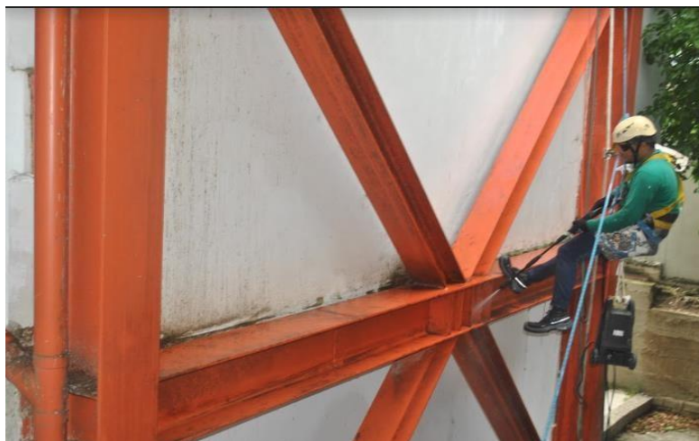
Figura 23. Aplicación de Creolina en puntos críticos. Fuente: Los autores
