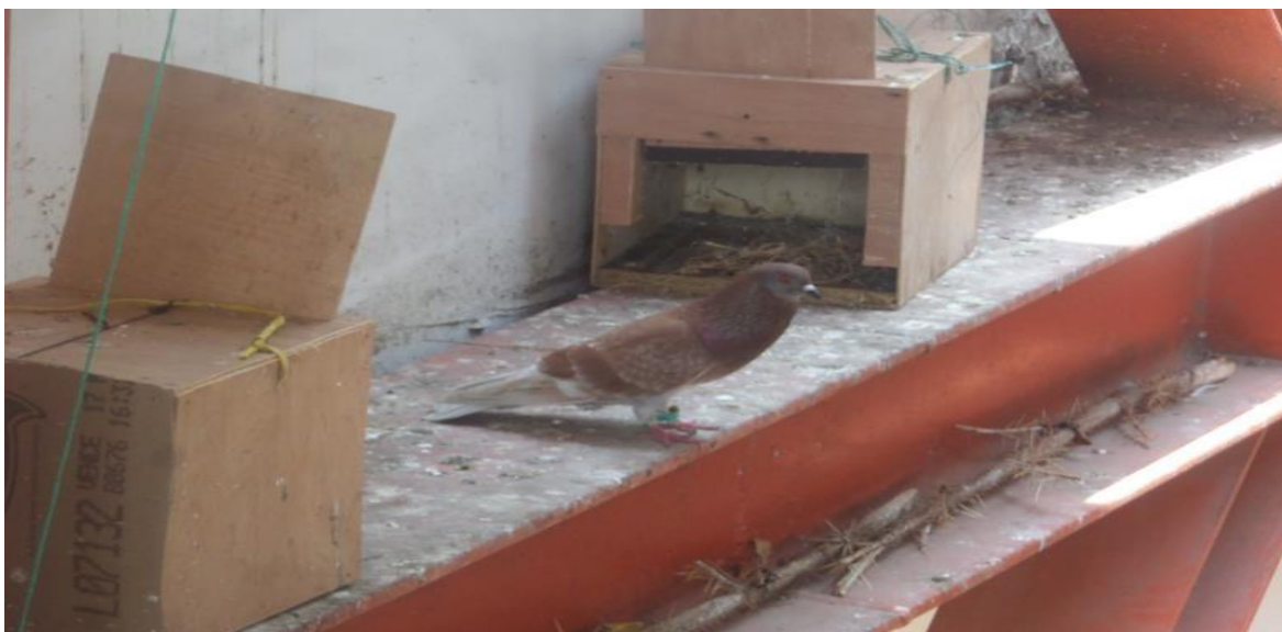
Figura 30. Instalación de Nidos trampas. Fuente: Los autores.
