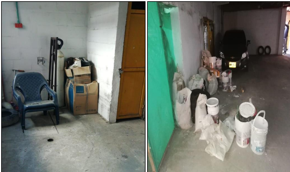
Figuras 10. Residuos encontrados durante la inspección.
