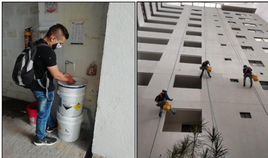
Figuras 12. Actividades del proceso de acabados (estucado).
