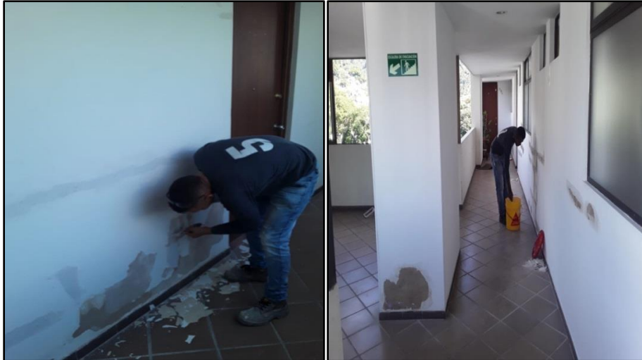
Figuras 11. Proceso de acabados (estucado). Fuente: Autores (2020)
