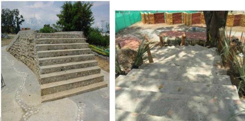
[Imagen Nos. 1 y 2 – Gradas elaboradas con escombros reprocessados](#)
