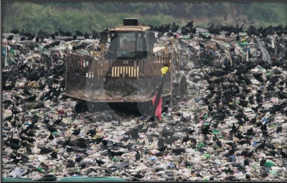
Figura 10. Fotografía del Relleno Sanitario
