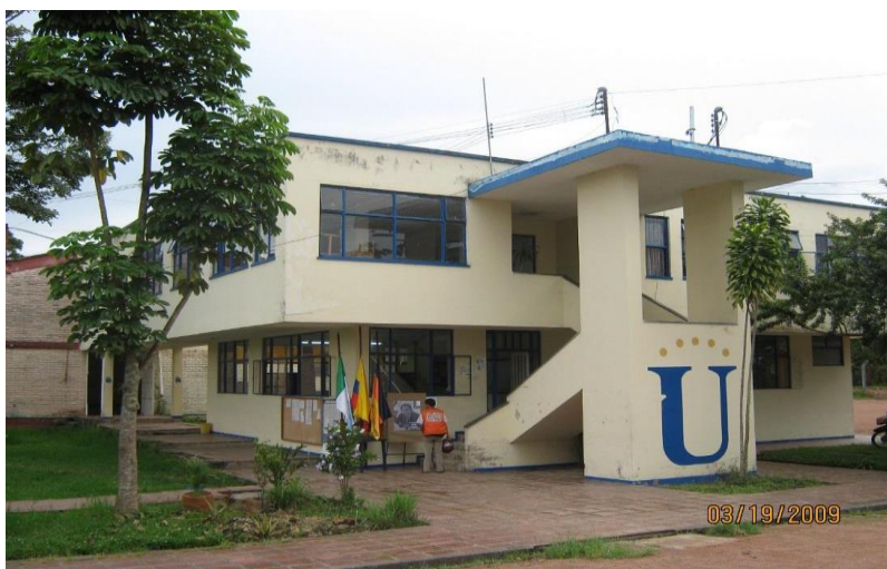
Fotografía 1. Sede de la UNAD CCAV Pitalito, antes de la remodelación
