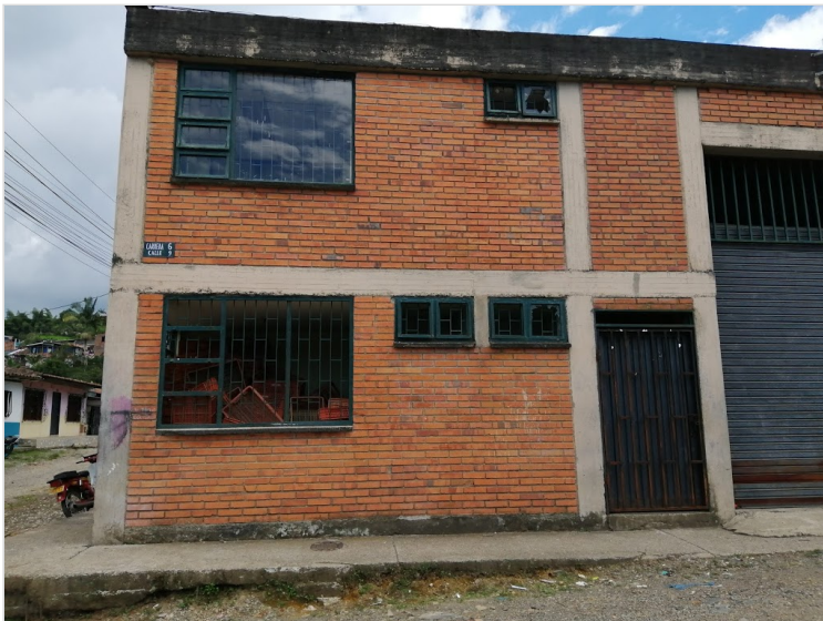
Ventanas con Vidrios Rotos, se observa corrosión en puertas
