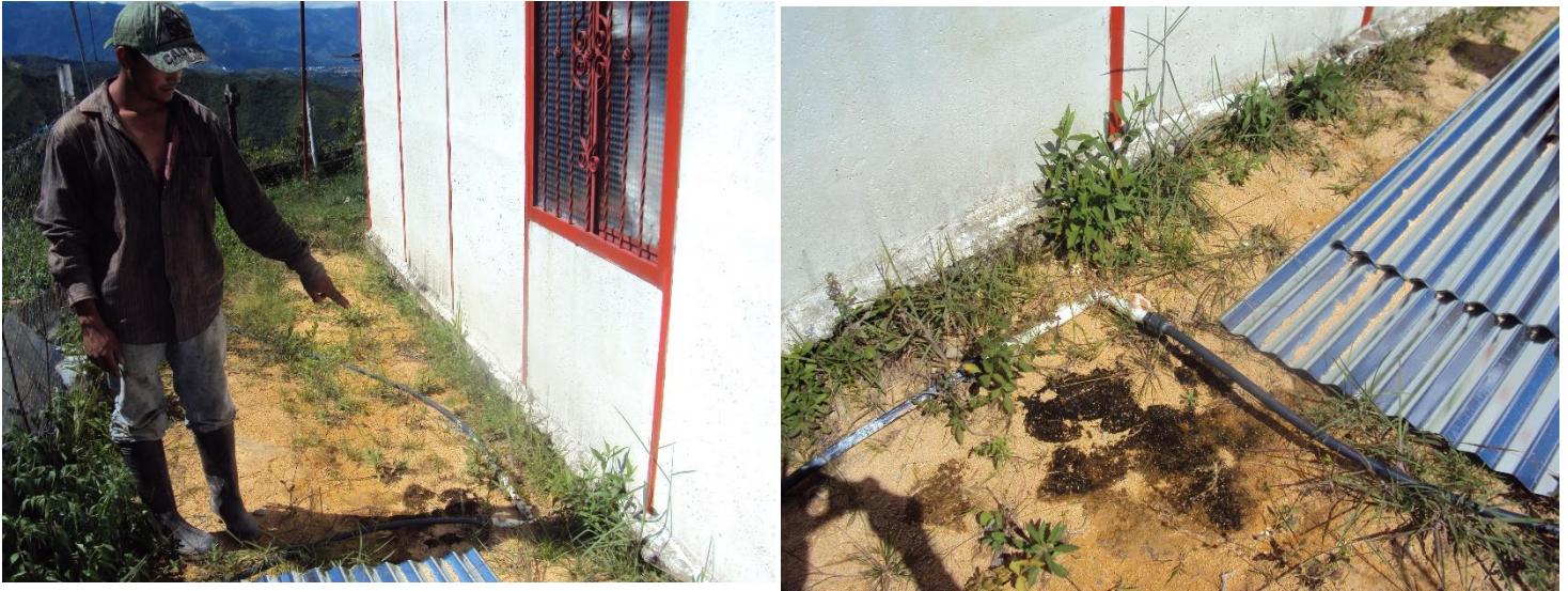
Cardona, M. (2016) Manguera del acueducto de una de la viviendas de la vereda [Figura 25]
