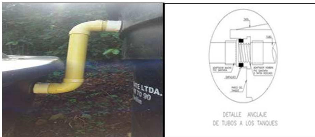
Figura 22. Detalle de instalación de accesorios
