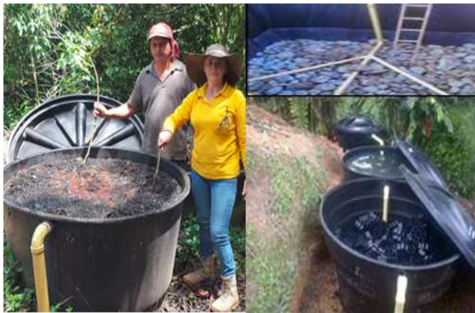
Figura 21 .Pozo de desnatado y ubicación de la planta de tratamiento
