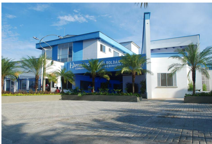
Figura 1. Sede Administrativa de la ESE HLIRV.
