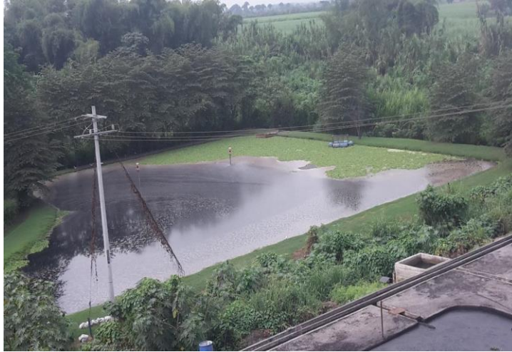
Imagen 9. Laguna de maduración o estabilización. Fuente: Elaboración propia
