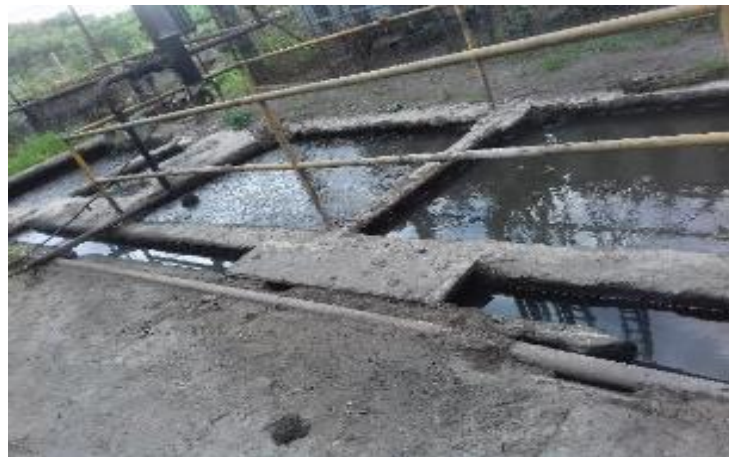
Imagen 6. Sistema de trampas de grasas de la PTAR del trapiche Lucerna. Fuente: Elaboración propia.
