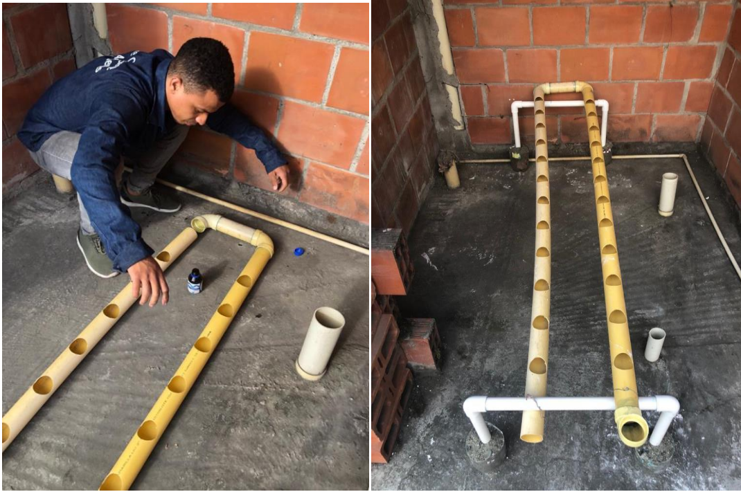
Fotografía No. 10 Instalación del Invernadero Parte 3 Fuente: EL autor (2020)
