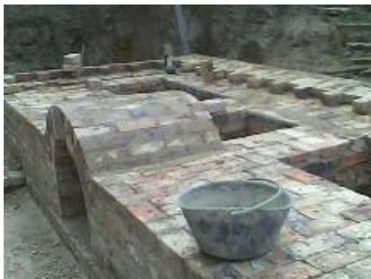
Figura 4 Horno Intermitente evolucionado
