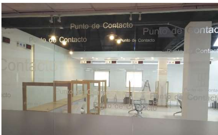
Imagen 3. Adecuación de zona de atención a usuarios
