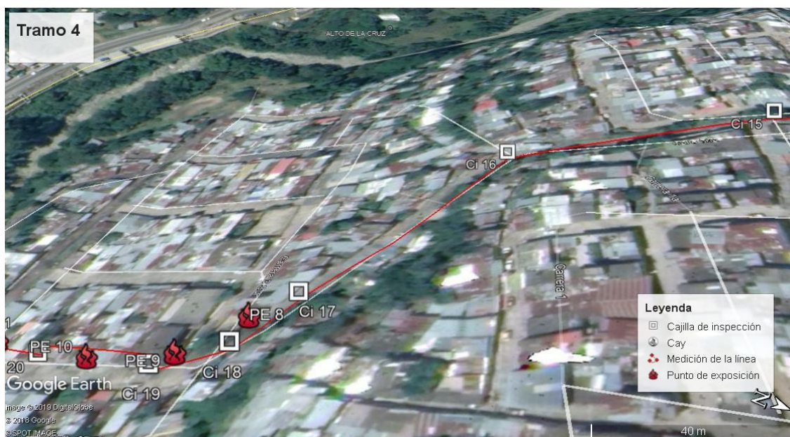
Figura 13. Tramo 4 Red de Alcantarillado Conectado al Hospital Federico Lleras Acosta. Fuente: Google Earth. (2019) Red de Alcantarillado. Ibagué. Colombia
