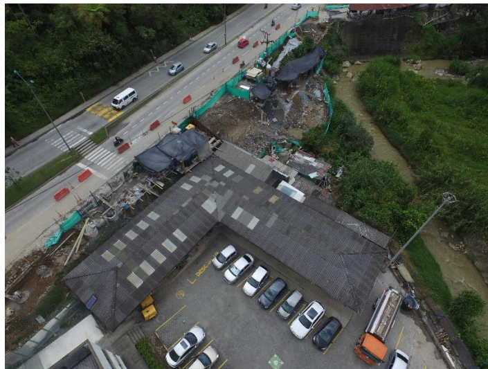
Ilustración 11 Cubierta del almacén y espacio del personal operativo sede principal Aguas de Manizales S.A. E.S.P. fuente proceso de administración logística 2019.
