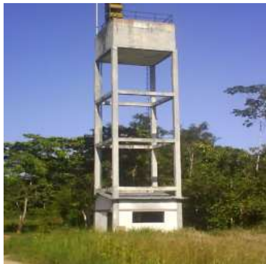
Tanque Elevado y Motobomba
