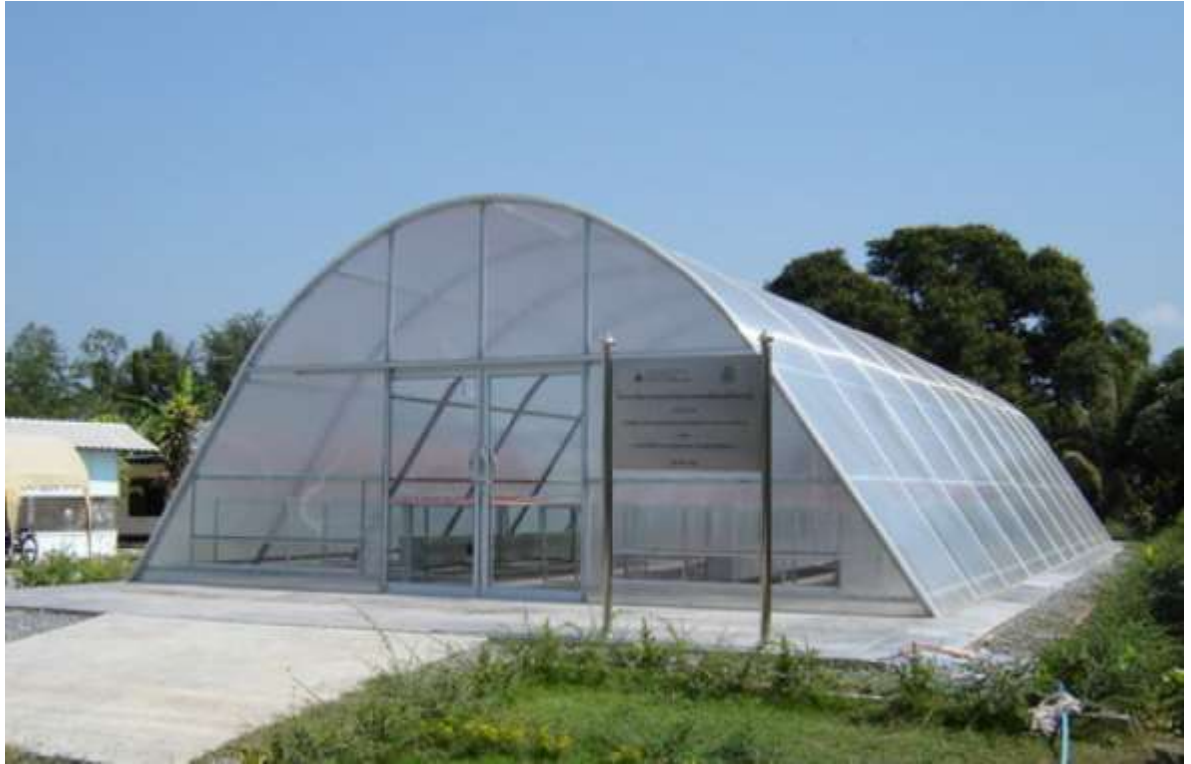
Figura 48. Secador activo tipo invernadero
