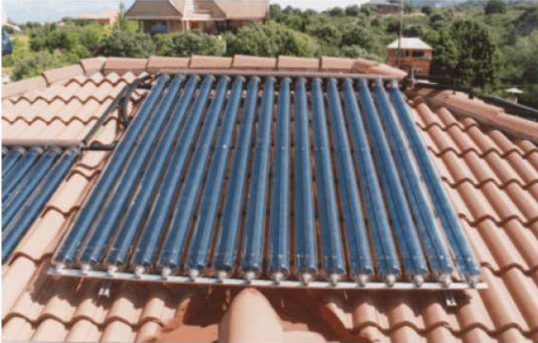
Figura 40. Colector solar de tubo de vacío heat pipe Fuente: [58]
