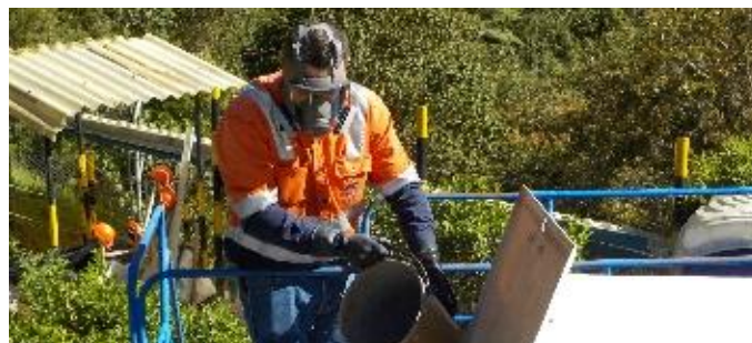
Anexo 4. Aplicación de PAC a la planta de tratamiento de aguas residuales domésticas.
