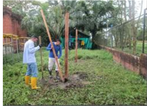
Aldana, K., González, J., Macias, F., (c. 2013). "Colocación de las vigas que hacen parte de la infraestructura." (Fotografía). Universidad Nacional Abierta y a Distancia. Acacias (Meta).
