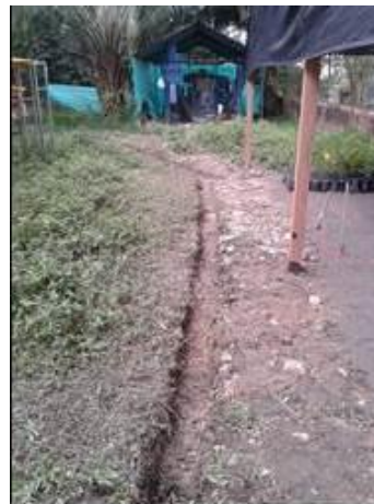
Aldana, K., González, J., Macías, F., (c. 2013). "Zanja de drenaje." (Fotografía). Universidad Nacional Abierta y a Distancia. Acacias (Meta).
