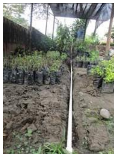
Aldana, K., González, J., Macias, F., (c. 2013). "Longitud de la tubería del sistema de riego." (Fotografía). Universidad Nacional Abierta y a Distancia. Acacias (Meta).
