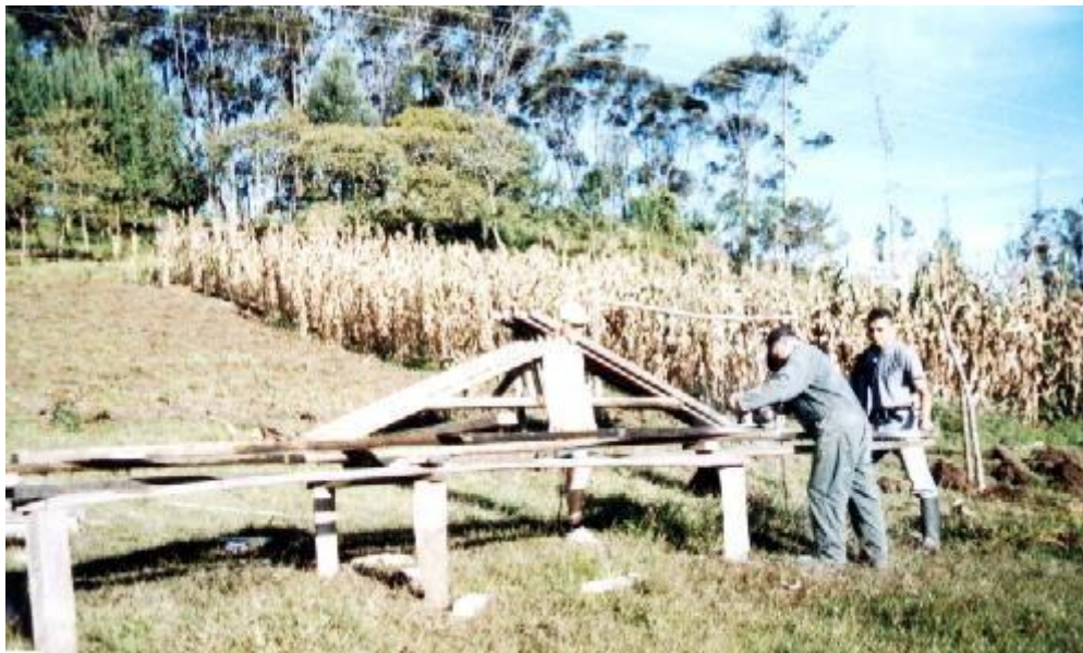
Foto No. 5 Levantado de Invernaderos Finca El Recuerdo, San Isidro de Ubalá
