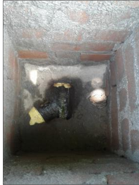
Foto 3. Reconocimiento sistema de tratamiento de aguas residuales (pozo séptico)
