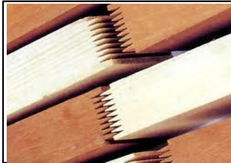
Figura 30: Uniones mediante Finger- Joint
