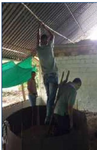
Figura 10 Adecuacion de vias de agua para bebederos automaticos.
