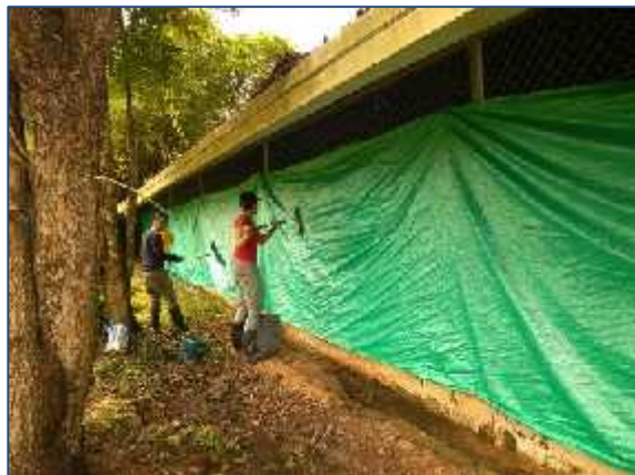
Figura 4 Limpieza de cortinas del galpón.
