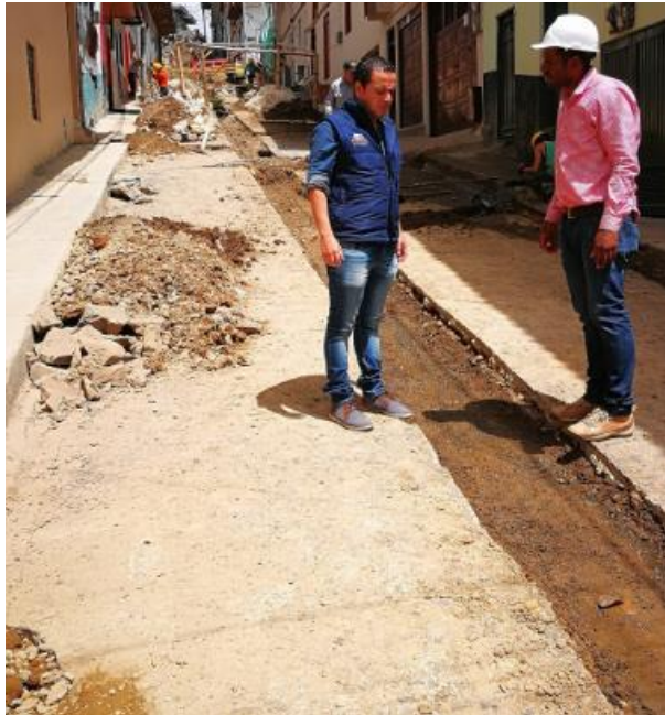
Ilustración 9. Mejoramiento de alcantarillado
