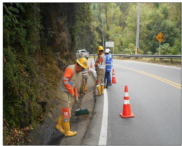
Fotografía N°2. Limpieza de cunetas PR70+420.
