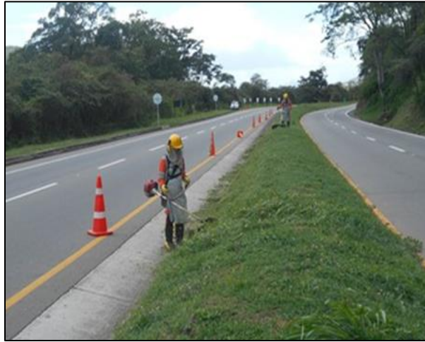
Fotografía N°9. Rocería y limpieza de material PR125+300.
