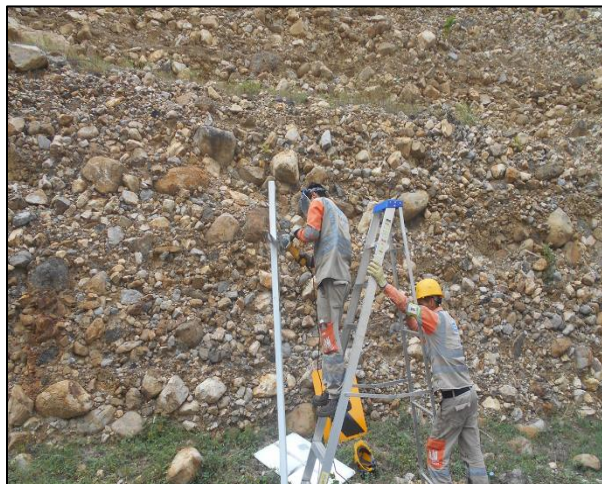
Fotografía N°5. Cambio delineador de curva horizontal SP-75 PR122+700.
