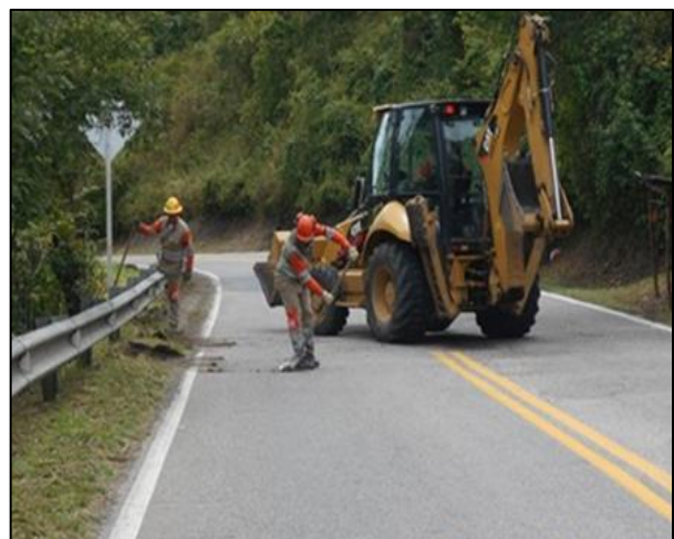
Fotografía N°12. Limpieza borde de Calzada PR98+200.
