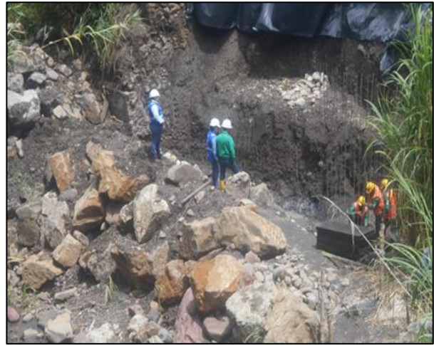
Fotografía N°14. Construcción de muro PR85+500.
