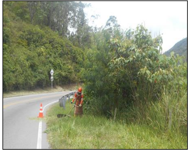
Fotografía N°10. Rocería y limpieza de material PR84+320.
