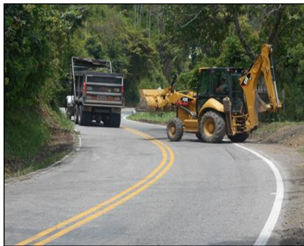
Fotografía N°11. Cargue de material proveniente de limpieza borde de Calzada PR109+250.
