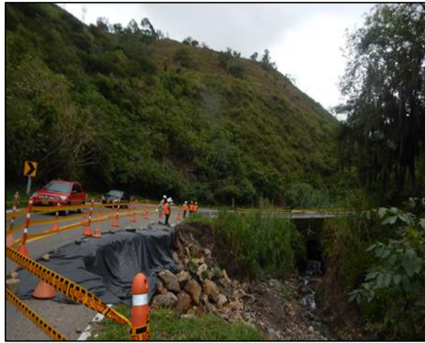
Fotografía N°13. Enrocado Roca Caliza muro PR85+500.
