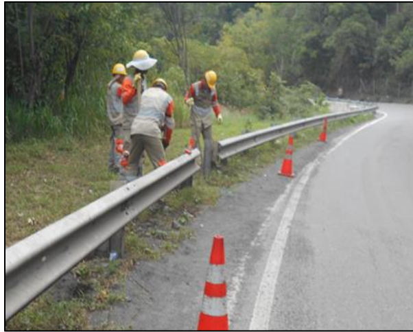
Fotografía N°7. Instalación de barrera metálica PR118+700.
