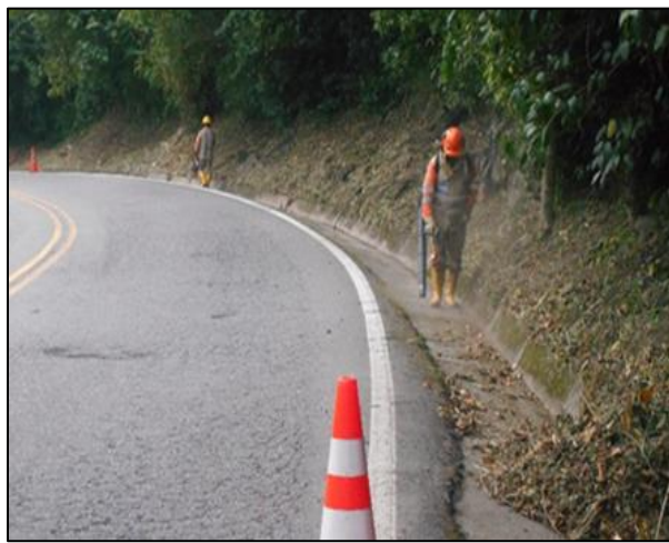
Fotografía N°1. Limpieza de cunetas PR91+300.
