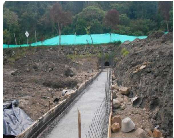
Fotografía N°4. Adecuación del Zodme PR91+300.
