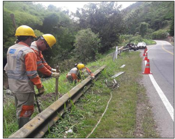
Fotografía N°8. Instalación de barrera metálica PR93+400.
