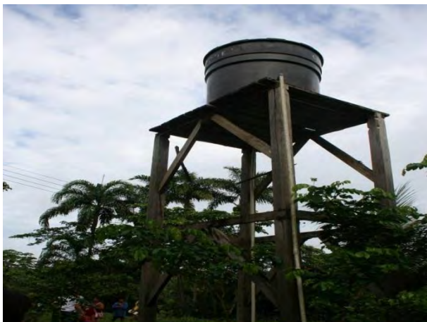
Ilustración 50. Pacera del acueducto de 12 de octubre
