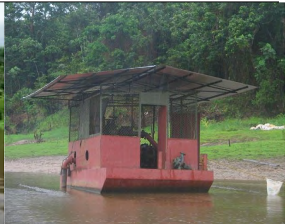
Ilustración 55. Vista General de la barcaza del acueducto
