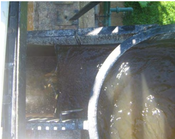
Ilustración 56. Canaleta Parshall del acueducto municipal
