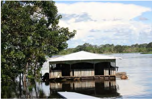
Balsa de localización de la motobomba utilizada por el internado para la captación de agua cruda del rio Loretoyacu
