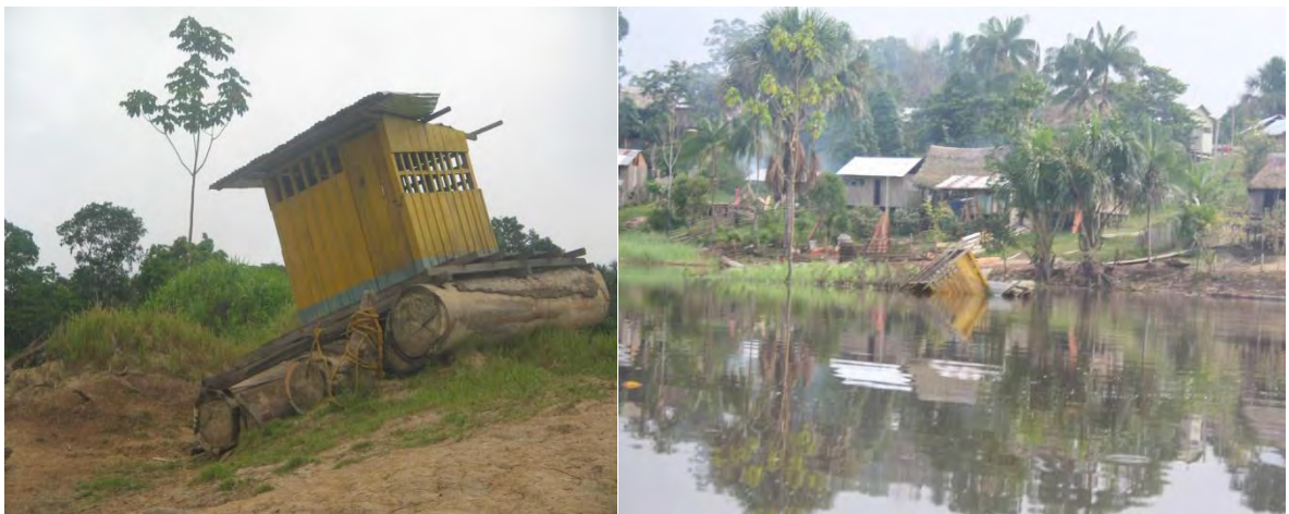
Ilustración 49. A la izquierda se muestra la balsa de máquinas en el 2008. A la derecha se muestra la balsa de máquinas en Junio de 2011.
