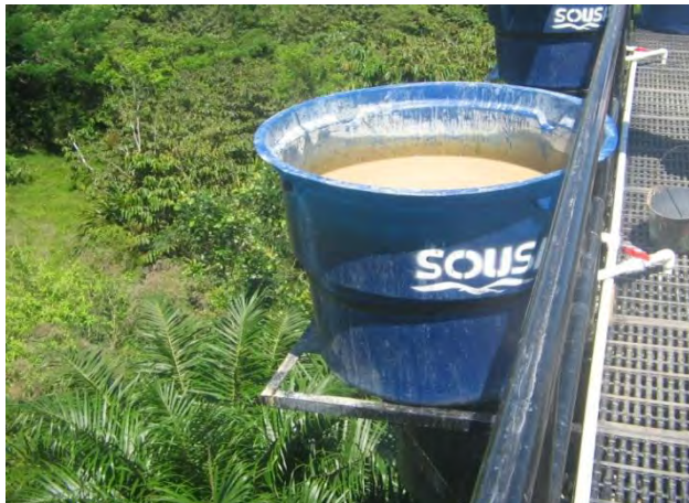
Ilustración 60. Dosificadores de sulfato de aluminio
