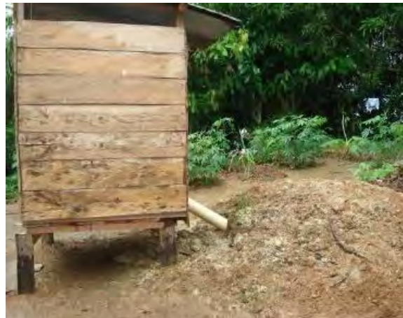
Ilustración 67. Tasa campesina con pozo séptico
