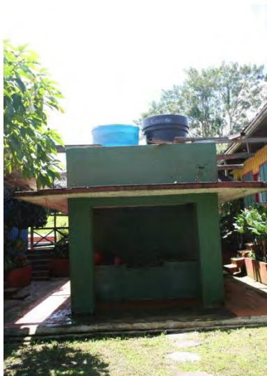
Batería sanitaria con tanque de almacenamiento que tiene conexión a aguas lluvias
