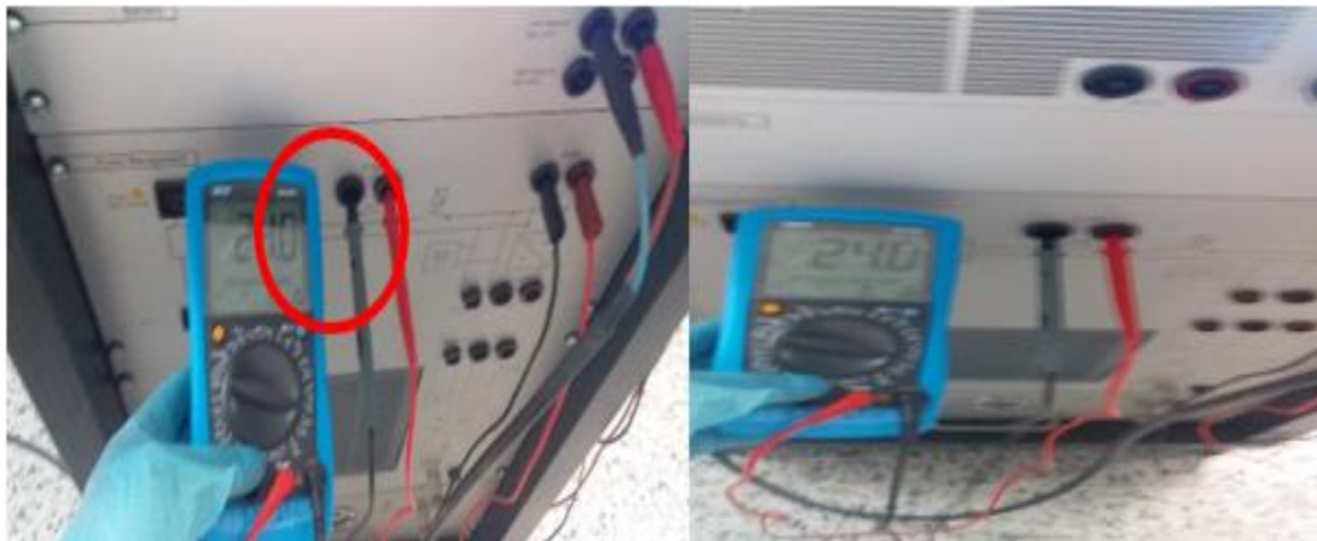
Figura 19 Verificación salidas voltaje modulo alimentación directo. Fuente: Propia
