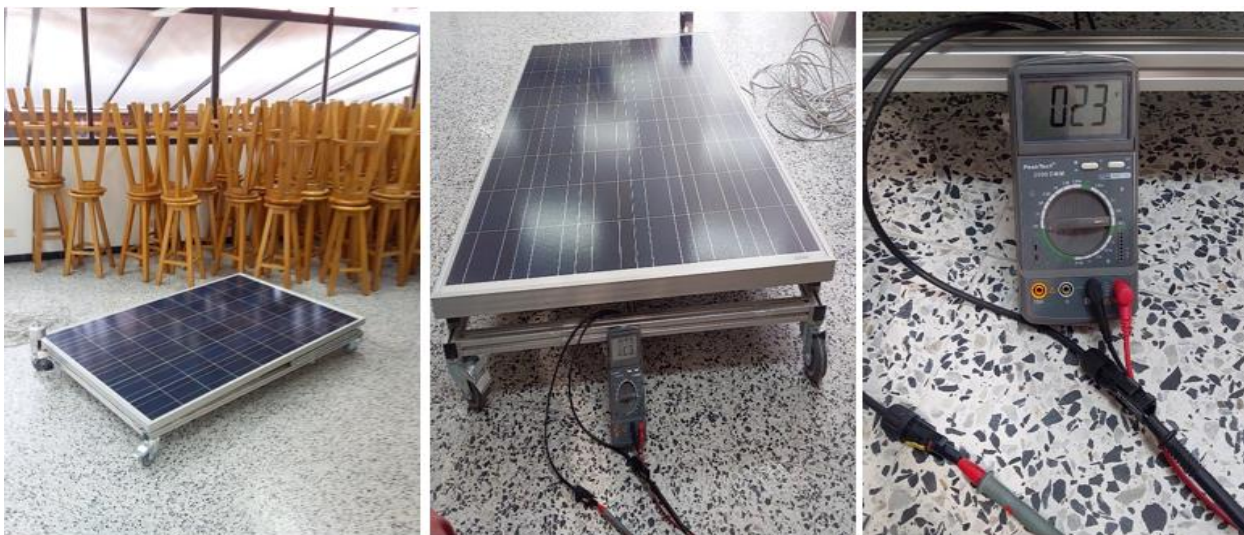
Figura 8 Medida generación voltaje dentro de instalaciones. Fuente: Propia
