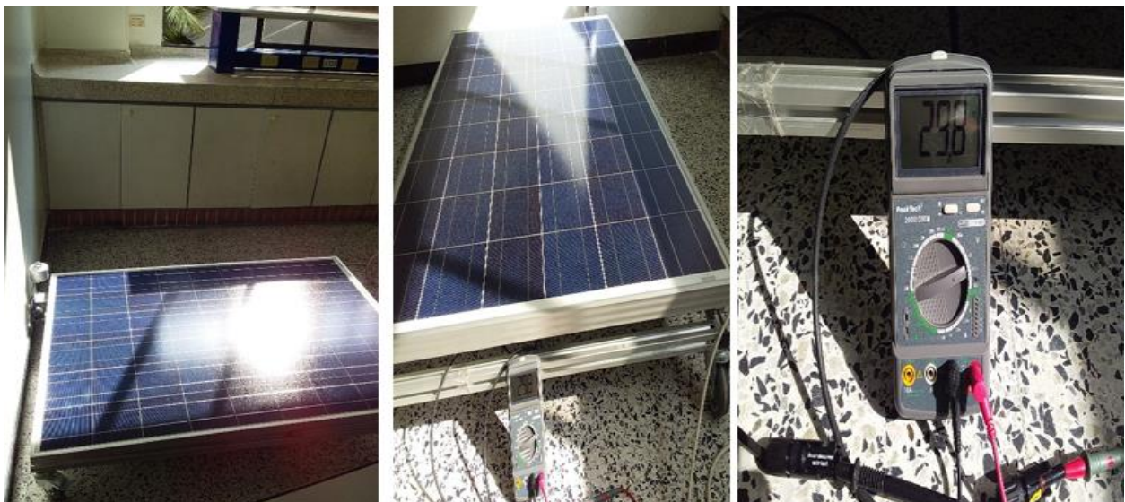
Figura 10 Medida voltaje con proyección solar por ventanas. Fuente: Propia
