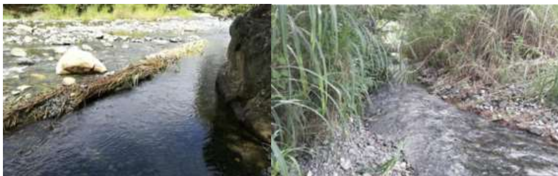
Ilustración 7. Fotos derivación 5, Acequia Grande
