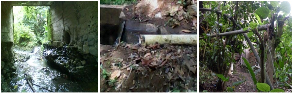
Figura 14. Vertimiento de aguas residuales de las viviendas. Vereda Ayacucho. Fuente: Autores
