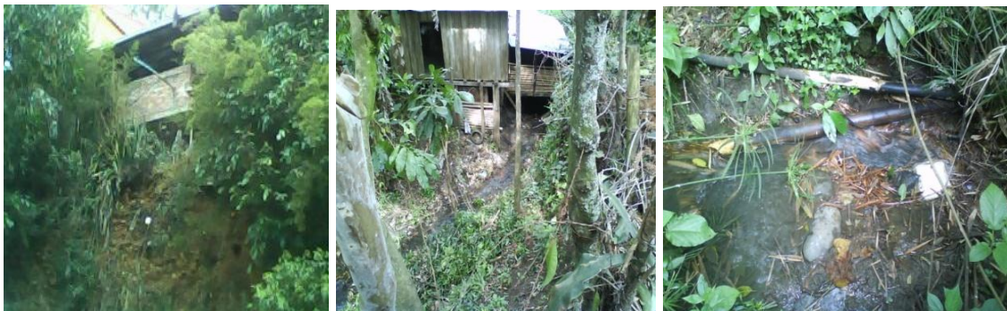
Figura 13. Vertimiento de aguas residuales de las viviendas. Vereda Chontaduro. Fuente: Autores
