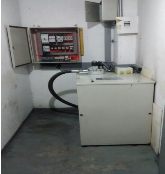
Cuarto de máquinas, central hidráulica, tablero de mandos y sistema de válvulas Foto obtenida en campo (autoría propia).
