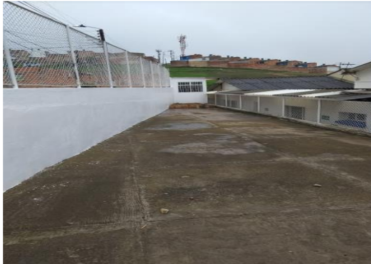
Imagen 2: Área exterior (costado occidental).
