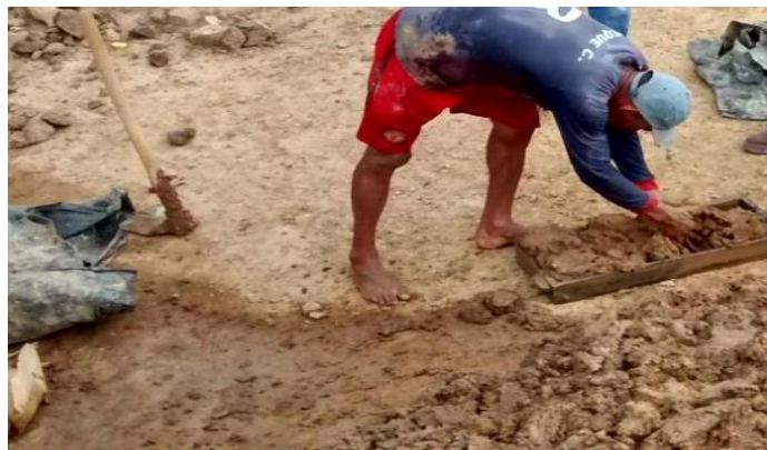
Figura 16: Moldeado. Fuente: los autores (2018).
