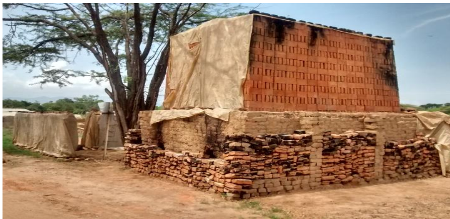
Figura 19: Enfriamiento. Fuente: Los autores (2018)
