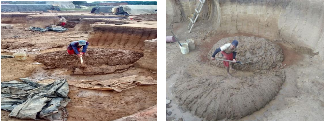
Figura 15: Mezclado- Volteado. Fuente: Los autores (2018).
