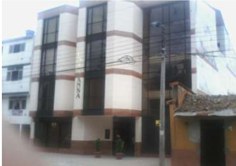
Figura 5. Edificio UNITRANSA S.A.
