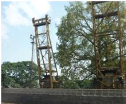
Figura N° 3 Grúa de paredón.
