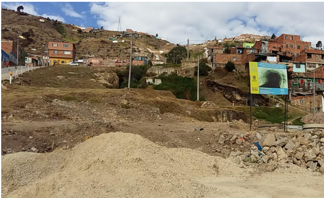
Figura 3: Viviendas construidas en zonas en riesgo de deslizamiento
