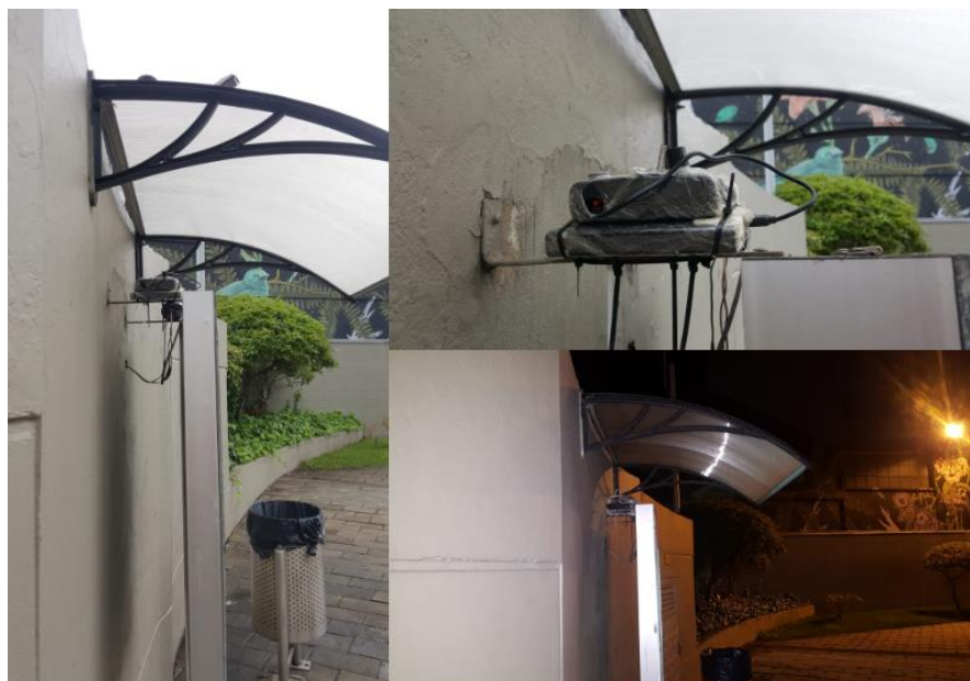
Ilustración 68. Instalación módulo 1 – Sede Carrera 13.
