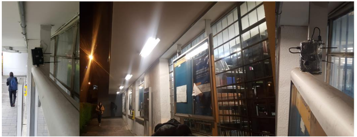
Ilustración 69. Instalación módulo 2 – Sede Carrera 13.
