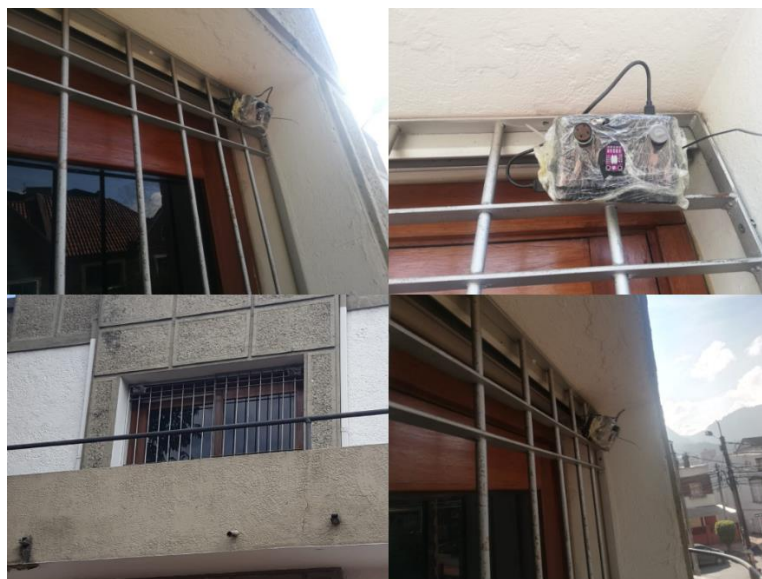
Ilustración 65. Instalación módulo 2 – Sede El Claustro.
