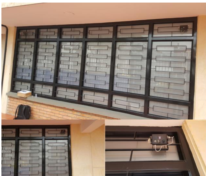
Ilustración 67. Instalación módulo 2 – Sede Las Torres.
