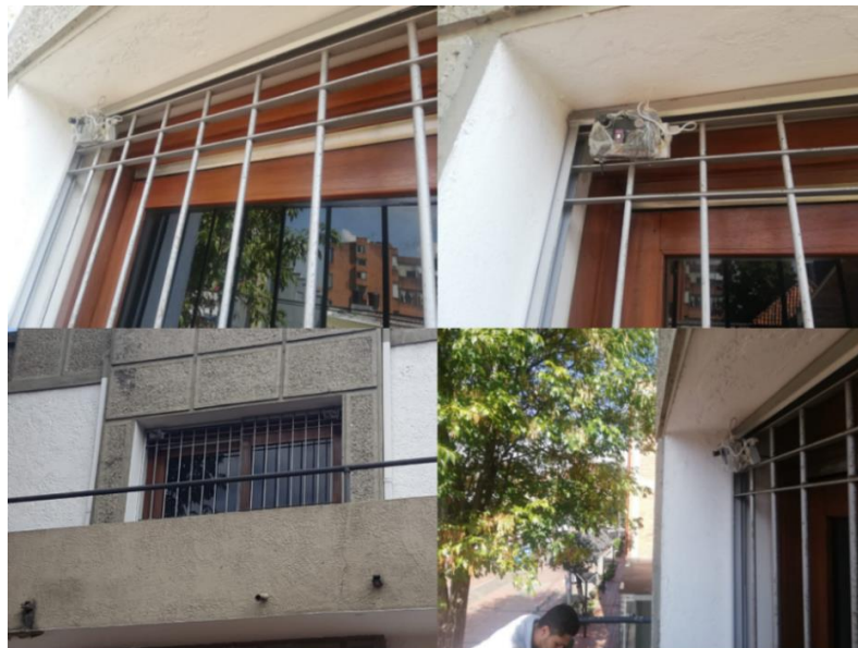
Ilustración 64. Instalación módulo 1 – Sede El Claustro.
