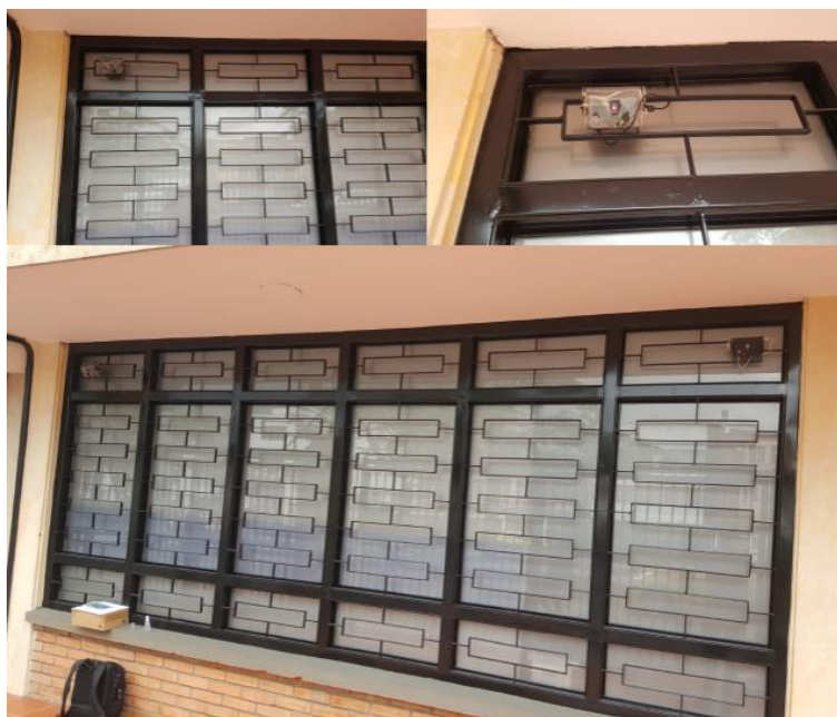
Ilustración 66. Instalación módulo 1 – Sede Las Torres.
