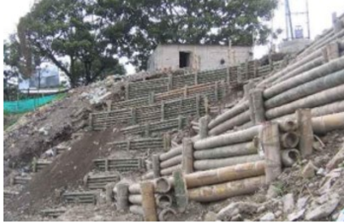
Imagen 4 Vista lateral de trinchos de Guadua, Palmares del Recreo, Armenia Quindio.
