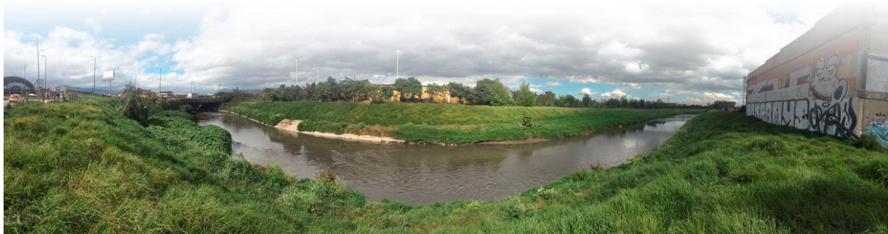
Figura 8. Registro fotográfico. Panorámica del contexto inmediato.
