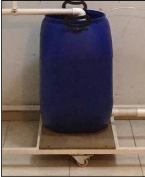
Ilustración 30. Instalación de base para el tanque 2.
