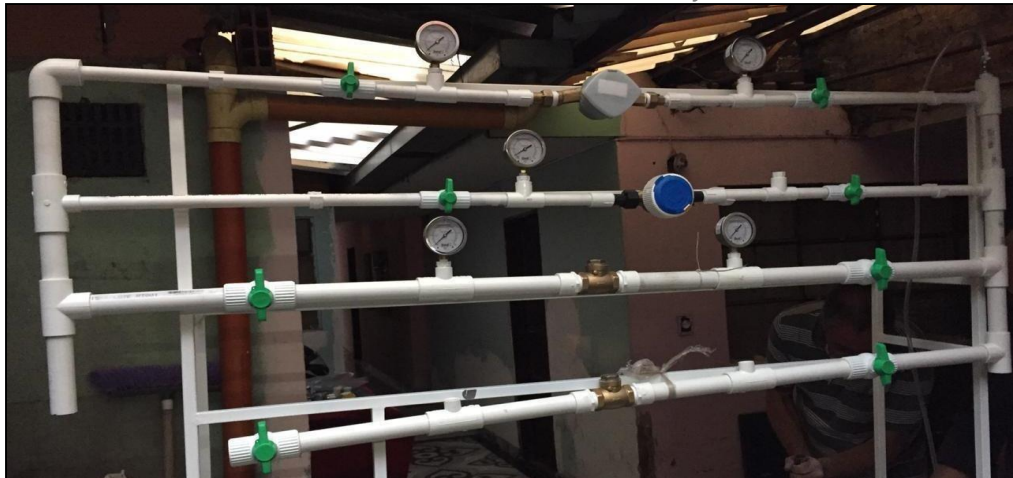
Ilustración 29. Instalación de tubería y accesorios.
