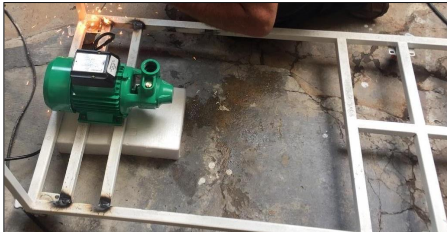
Ilustración 19. Instalación de la bomba.
