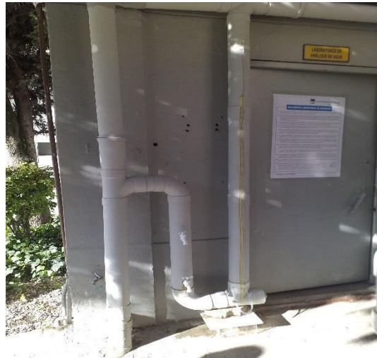
Ilustración 14. Sistema de filtración totalmente construido.
