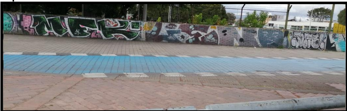
Figura 17. Tramo Cicloruta Av. Calle 80 con 76 Demarcado con Pintura de Alto Impacto Azul
