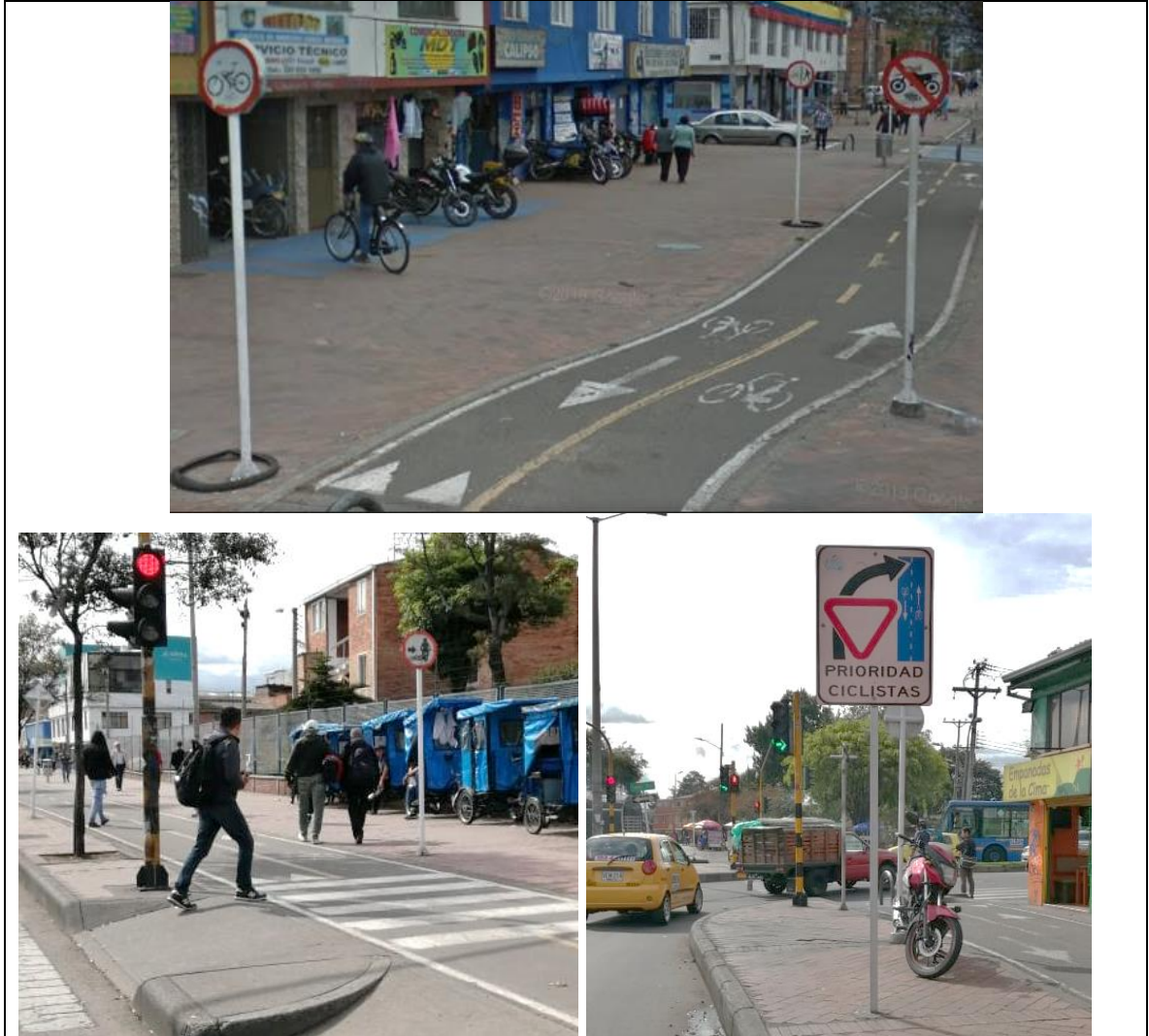
Figura 19. Señalización de la cicloruta bien ubicada
