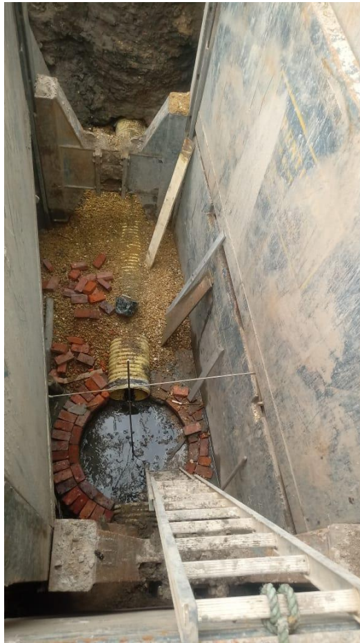
Ilustración 37. Entibado de Contención
