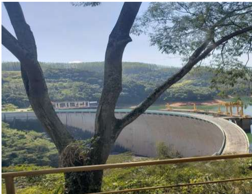
Figura 17 Vista exterior represa de Funil tipo doble arco.
