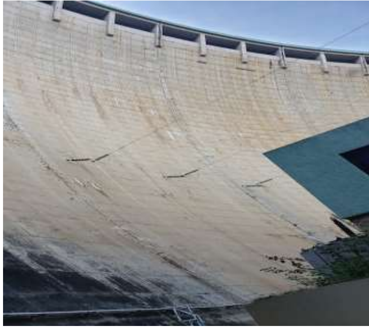
Figura 8. Muro de Contención represa Funil
