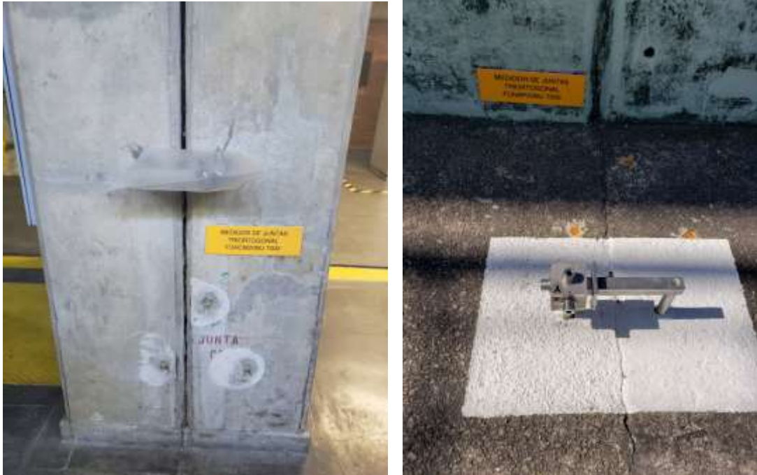
Figura 15 Medidores de dilatación zona inferior central hidroeléctrica.
