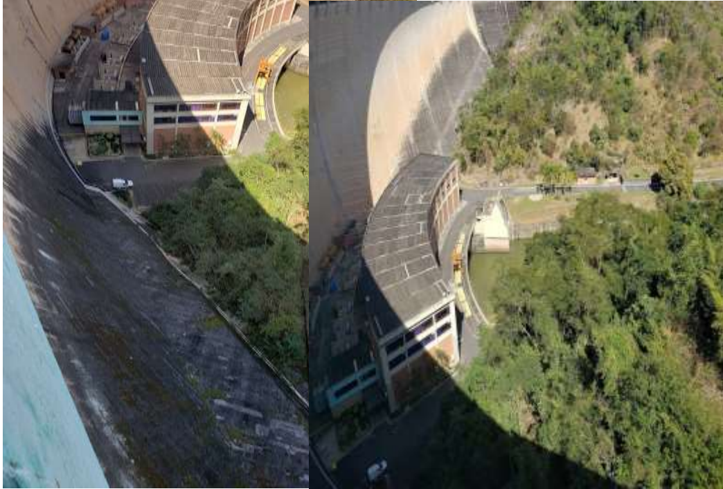
Fotografías vistas desde la parte superior de la casa de máquinas
