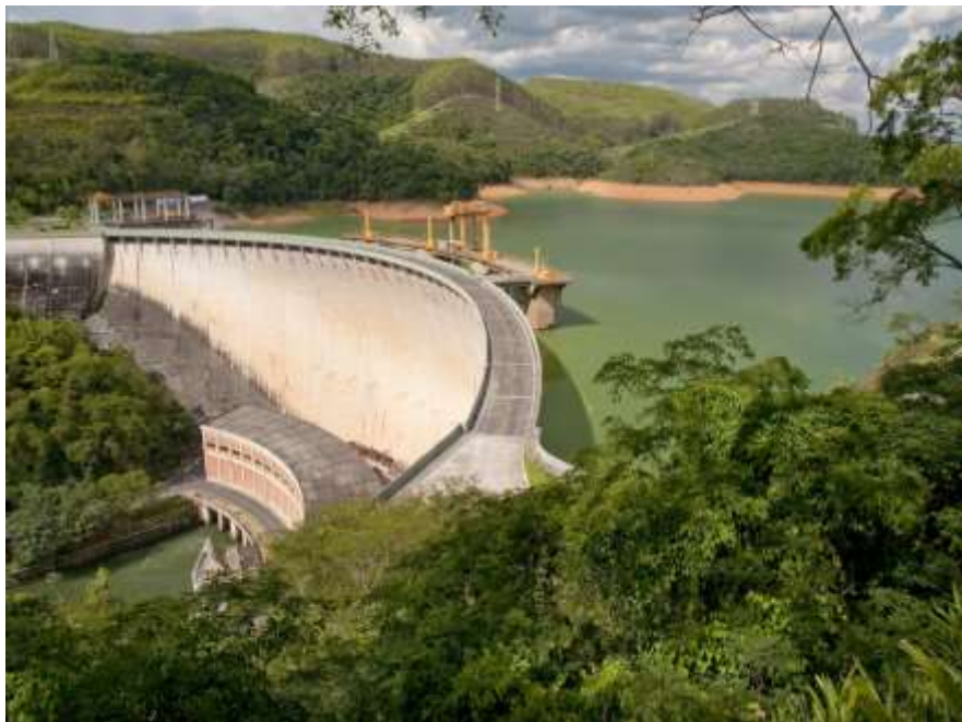
Figura 2. Represa de Funil - Río de Janeiro, represa Tipo bóveda
