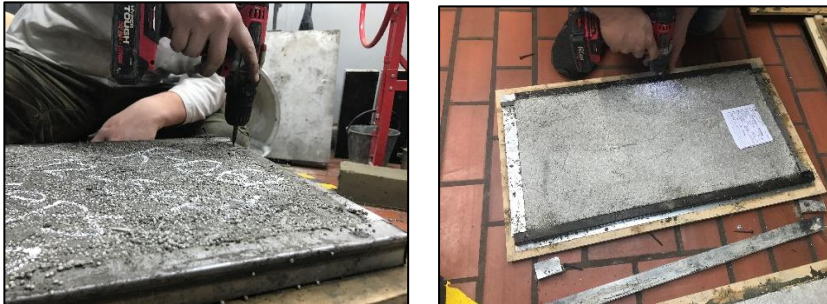
Figura 82. Desencofrado de láminas
