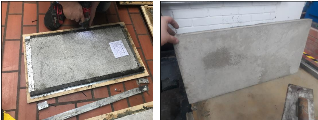
Figura 47. Proceso de desencofrado de las láminas diseñadas
