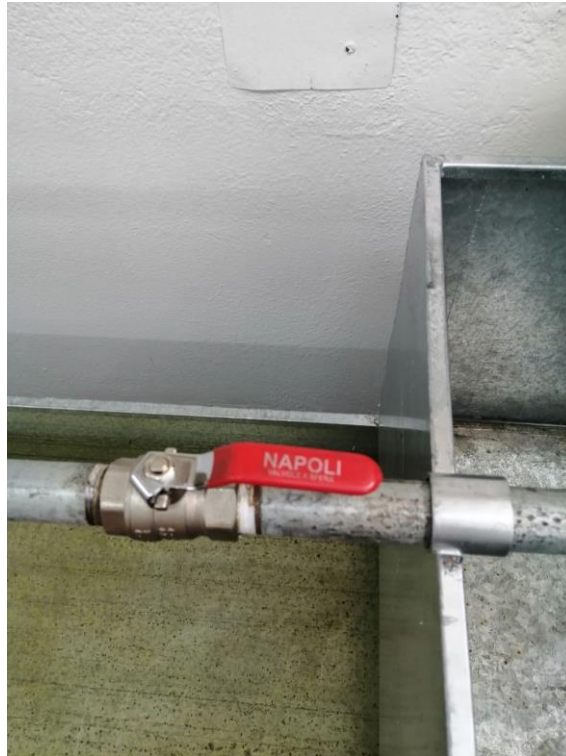
Figura 10. Válvula de regulación (válvula de bola)
