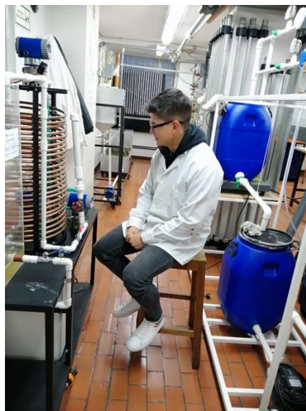
Figura 16. Ensayo de cámara de quiebre de presión
