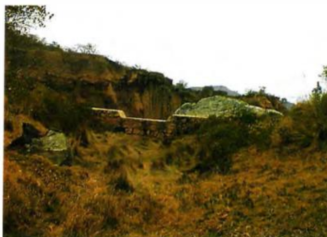
Ilustración 59. Muro en piedra pegada construido en la Cuenca del Río Checua
