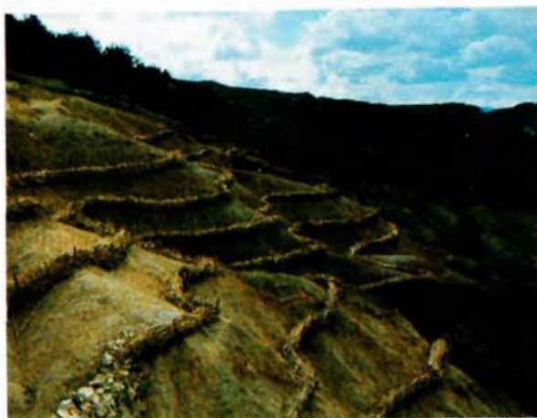
Ilustración 58. Fajinas colocadas en ladera
