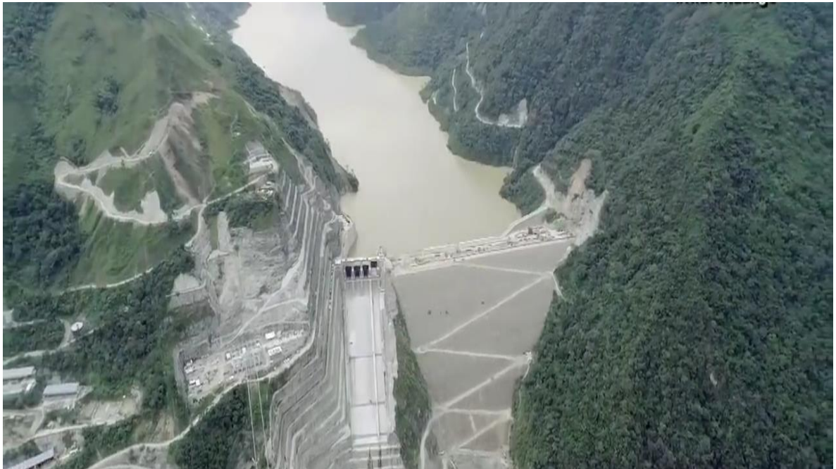
Figura 36. Ubicación de la represa Hidroituango
