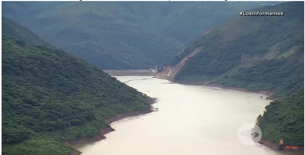
Figura 35. Ubicación de la represa Hidroituango
