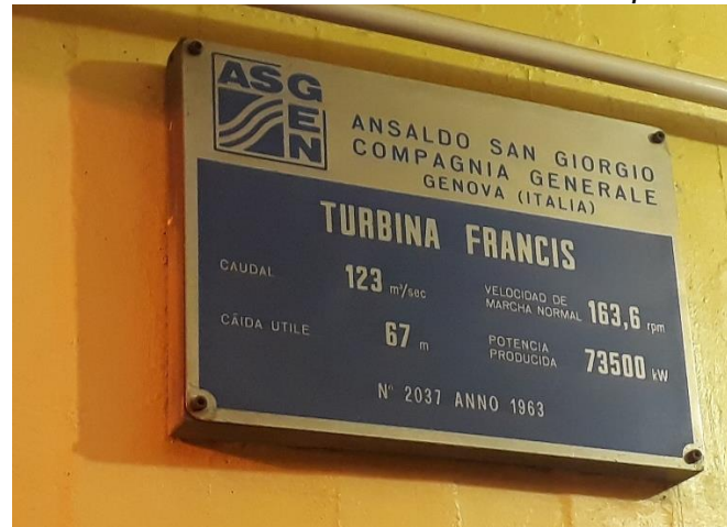
Figura 13. Características de las turbinas de la represa Furnas
