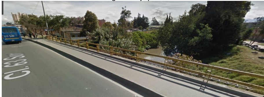
Ilustración 10. Toma 2. Aguas abajo puente calle 63 sur #81 f 38
