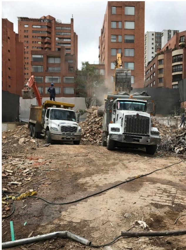
Ilustración 12 – Volquetas; Fuente: Autores
